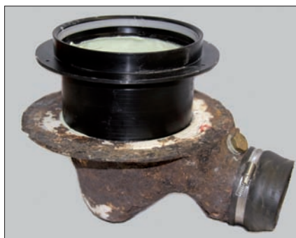
Muovisen korokerengaan tiiveystesti
