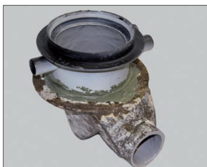
Muovinen korokerengas kiinnitetty vedenpitävällä New Tube Foamilla
