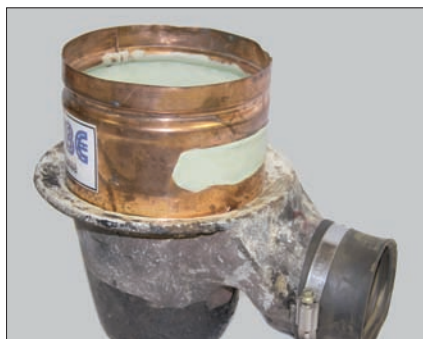
Kuparisen korokerengaan tiiveystesti, sivuliitäntä paikkauksella
